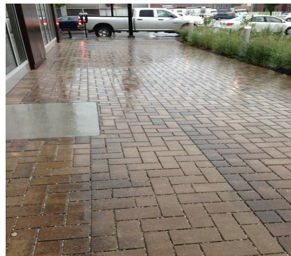
Permeable paver sidewalk in Des Moines
